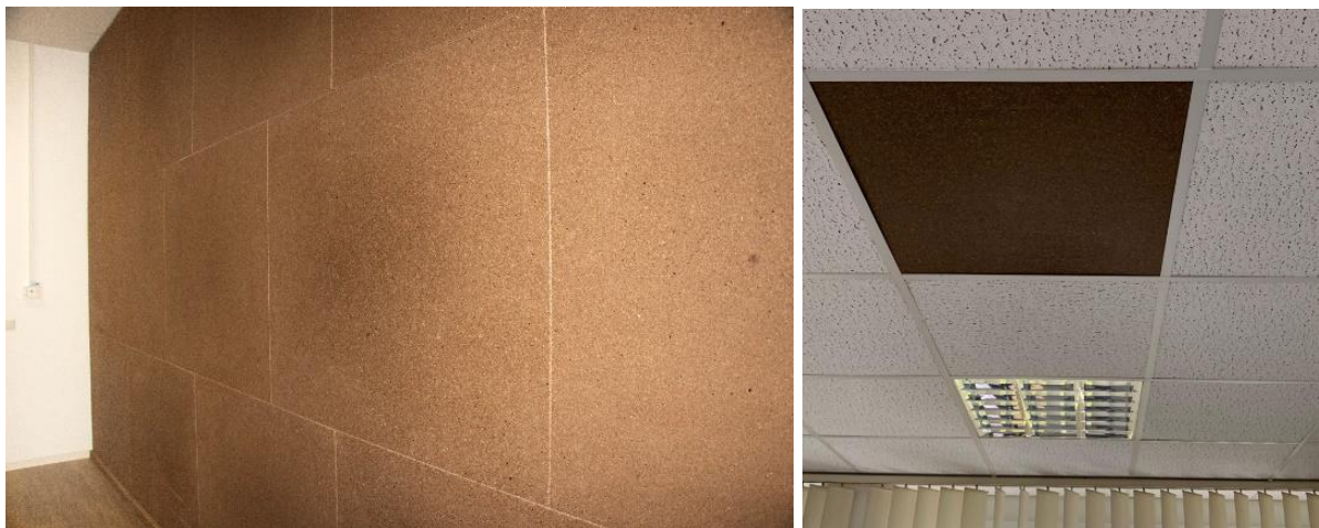
Schallschutz-Verkleidung in einem Bildungszentrum in Mannheim (links) und ein Deckenpaneel in einem Bürogebäude (rechts).
